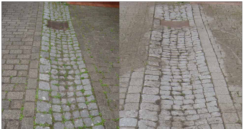
Der Vorher-nachher-Effekt ist deutlich. Mit einem zweiten Durchgang werden dann auch noch die letzten „grünen Inseln“ beseitigt
